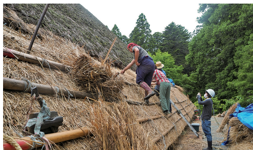
逢善寺書院の屋根の葺き替え現場
