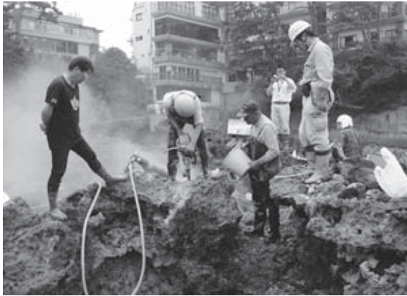
図 1. 2006年6月に実施された発掘調査。海岸法、漁業法関係諸手続きを経て、調査が実施された。削岩機のホースは、市道に置いたコンプレッサから約120m引き込んでいる。この図は道路のコンクリートを切るカッターでの作業状況。
