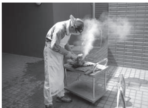
図6. ディスクグラインダーを使用し溝を入れる。このとき激しい騒音と粉塵が発生する。
