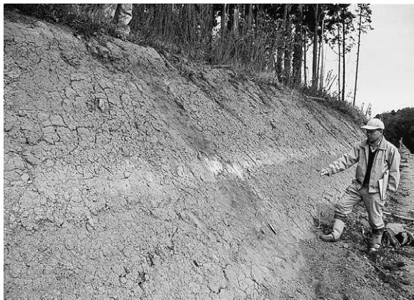
図 43. 東海村押延 露頭写真。
