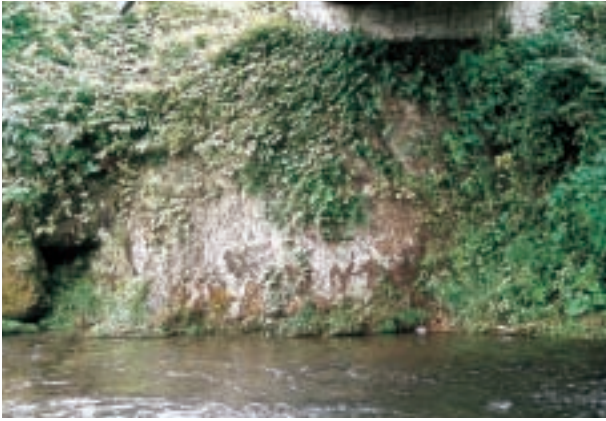
里川右岸橋下の破碎した花崗岩 (里美村和見)
