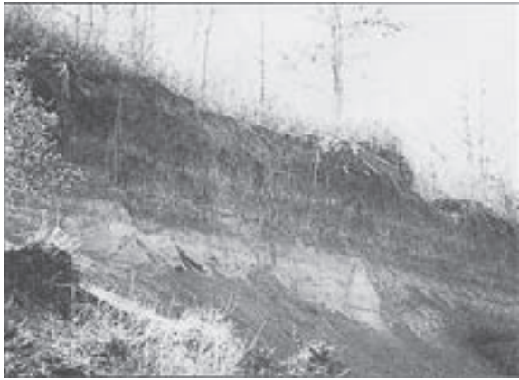
図46. 鹿島郡鉦田町借宿 露頭写真.
