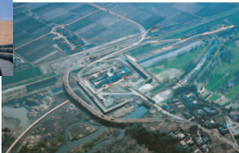
改築工事の様子（提供：境土木事務所）
