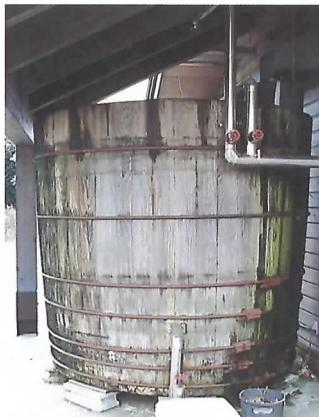
自然発見工房の建物のとなりにある装置で、この建物の屋根に降った雨水が自然にこの大きな樽に集まるようになっています。蓄えられた雨水はろ過器を通してきれいな水に変わります。
