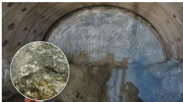
カタクレサイトが露出したトンネル工事現場の切羽 (左下:トンネル工事で産出したマイロナイト) (協力:茨城県常陸太田工事事務所)
