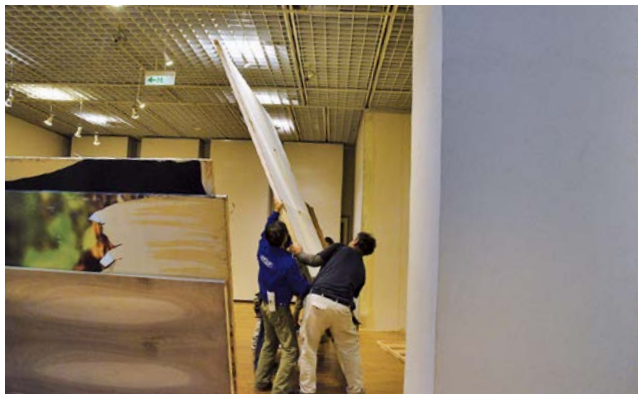
展示室の壁面を立てる工事
