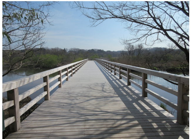
架け替え工事後の菅生沼ふれあい橋・あすなろ橋
