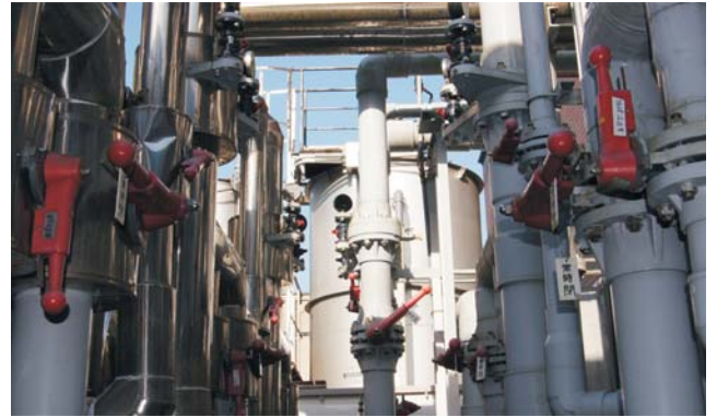
バックヤードの水処理設備
