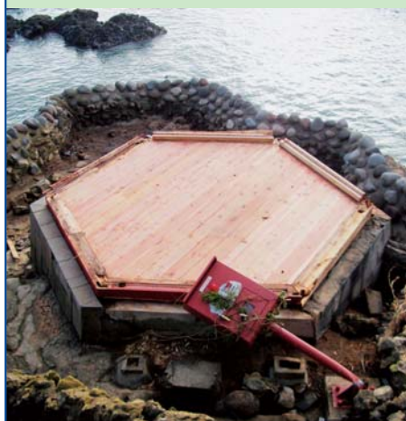
2011年3月、流失した六角堂跡に残された土台
