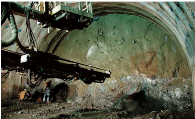
掘削工事中のトンネル内部 (2010.12.15)
