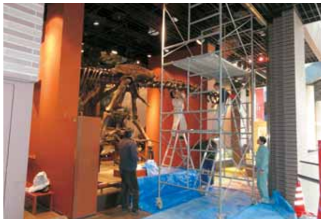
ティラノサウルスの補修と吊り元強化作業
