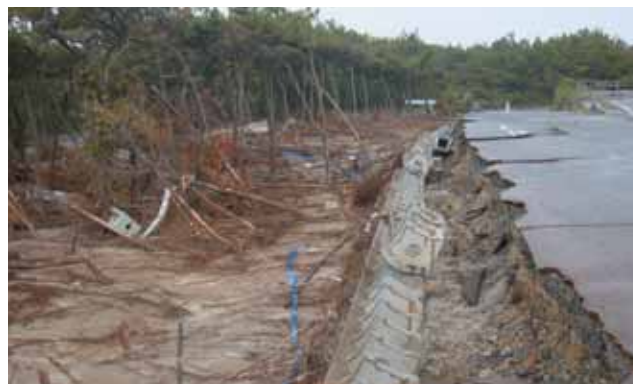
地震で路肩が崩落し、津波でなぎ倒された海岸林（いわき市）
