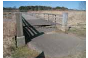
液状化現象によって管生沼にかかる橋が持ち上がって生じた段差
