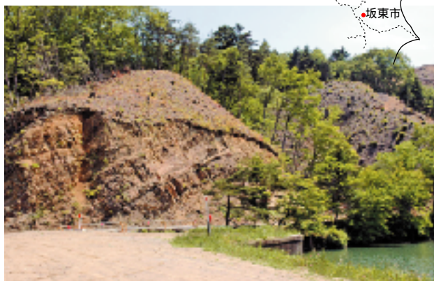
常磐道関連の工事が行われた崖(福島県南相馬市)
